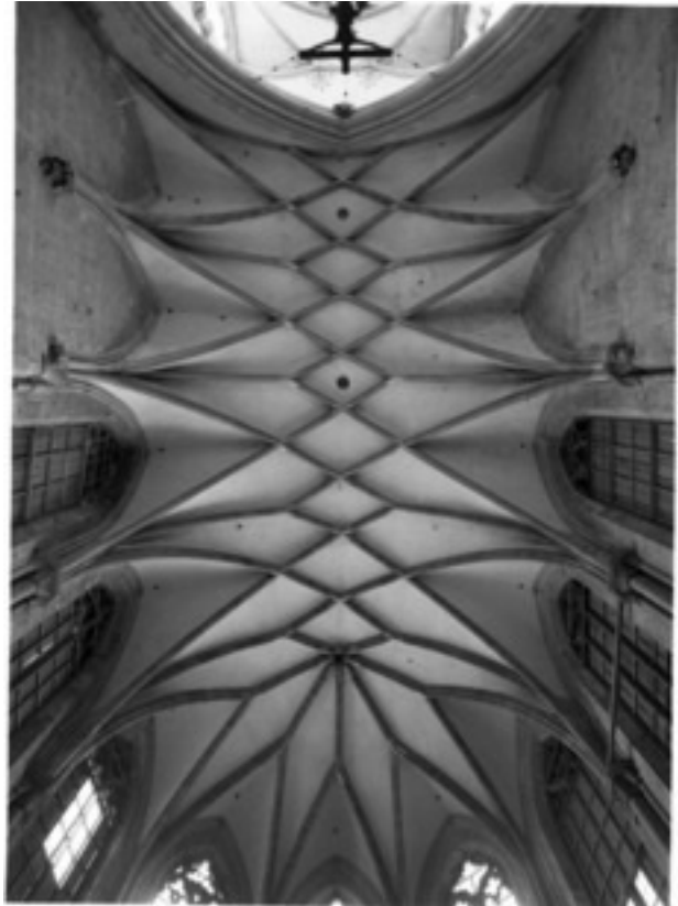
Chorgewölbe nach der Wiederherstellung
