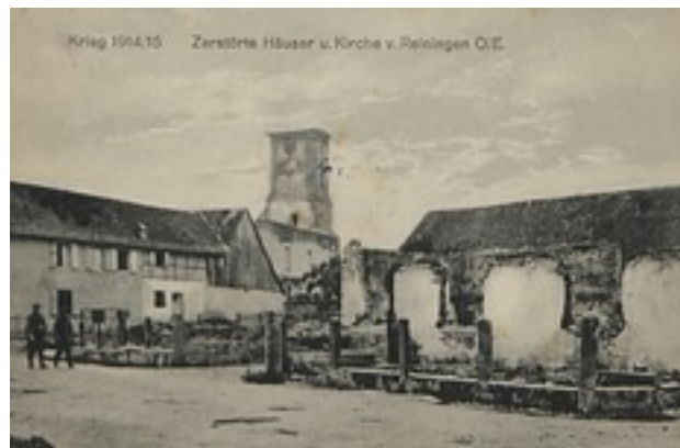
Bildpostkarte, Zerstörte Häuser aus Reiningen O/E., 29. August 1915
